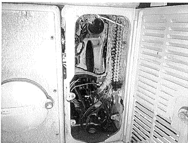
13-as fénykép: A kis elektromos kapcsolószekrény
