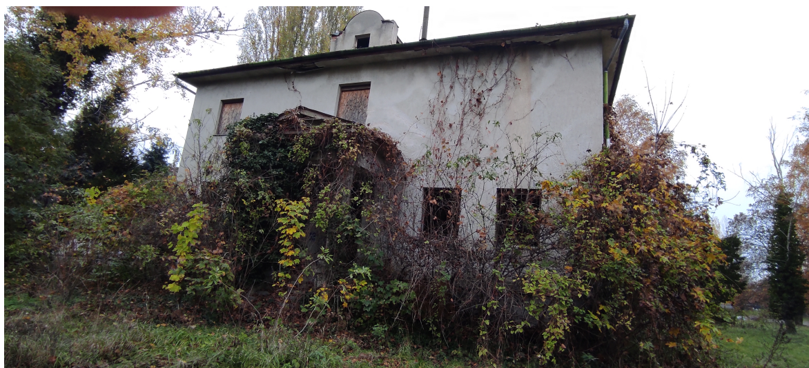
1. Épület nyugati homlokzata
