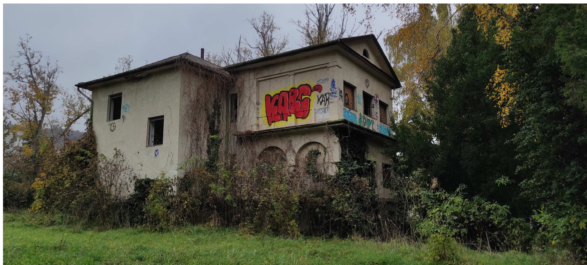
1. Épület déli homlokzata
