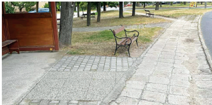
Megújul a budatavai járdaszakasz – forrás: Balatonalmádi FB oldala
